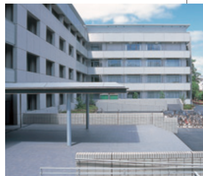
本館・南北棟
